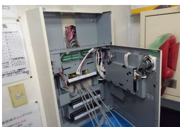
新品非常警報盤配線延長中
