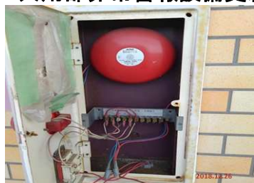
起動装置内部
