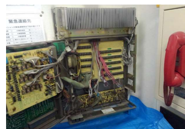
既存非常警報盤撤去中
